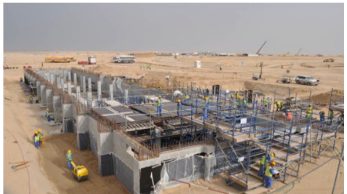
L'aluminerie de Ras Az Zawr de la coentreprise Ma'aden-Alcoa actuellement en construction
